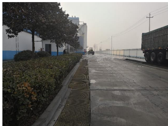
栽植乔灌草、排水暗沟
