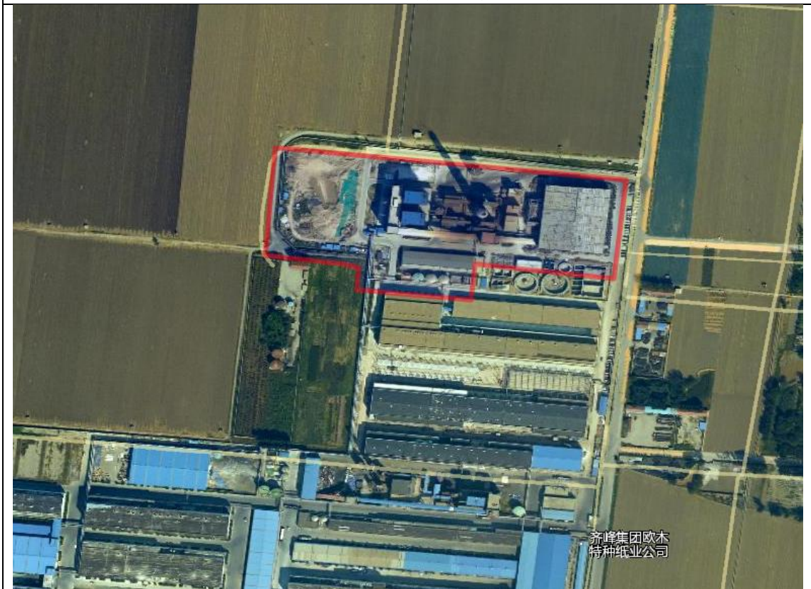
2015年9月份遥感影像照片（施工中）
