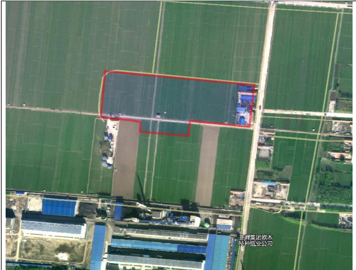
2012年4月份遥感影像照片（施工前）
