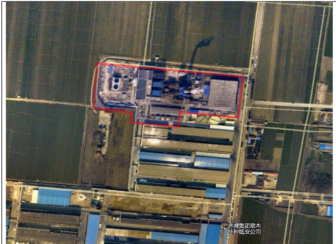
2017年2月份遥感影像照片（施工中）
