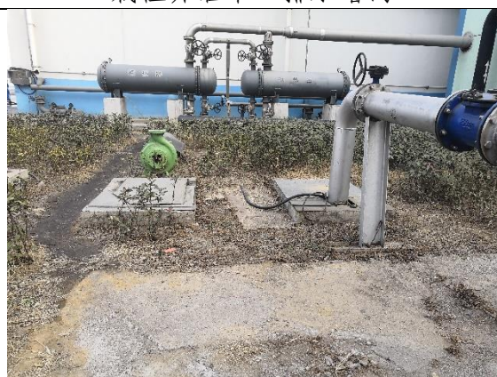
煤场雨水沉淀池
